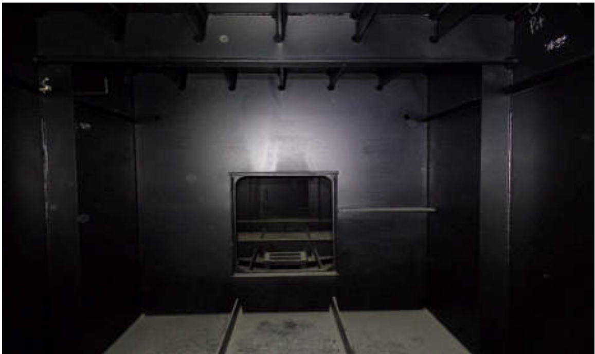
강박스 내부 전경
