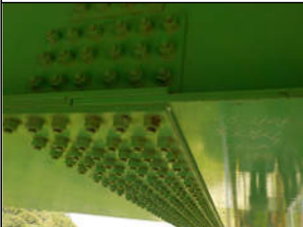
< 중앙부 : 스프라이스(Splice) 볼트연결부 >
