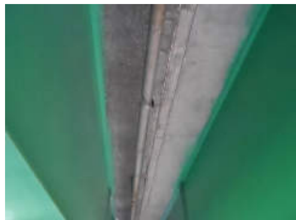
배수시설 전경 (여주)
